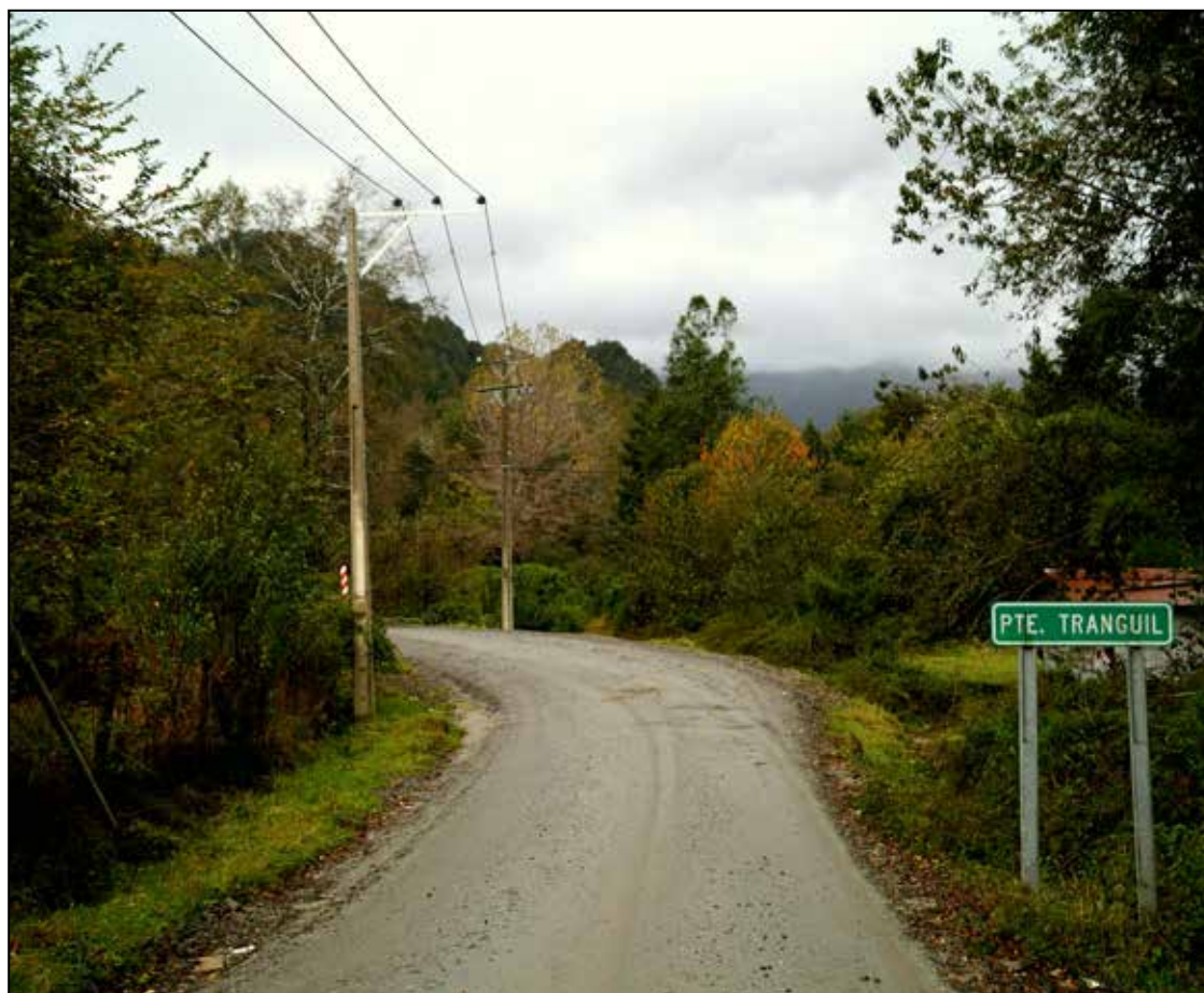
Camino y tendido en Tranguil
